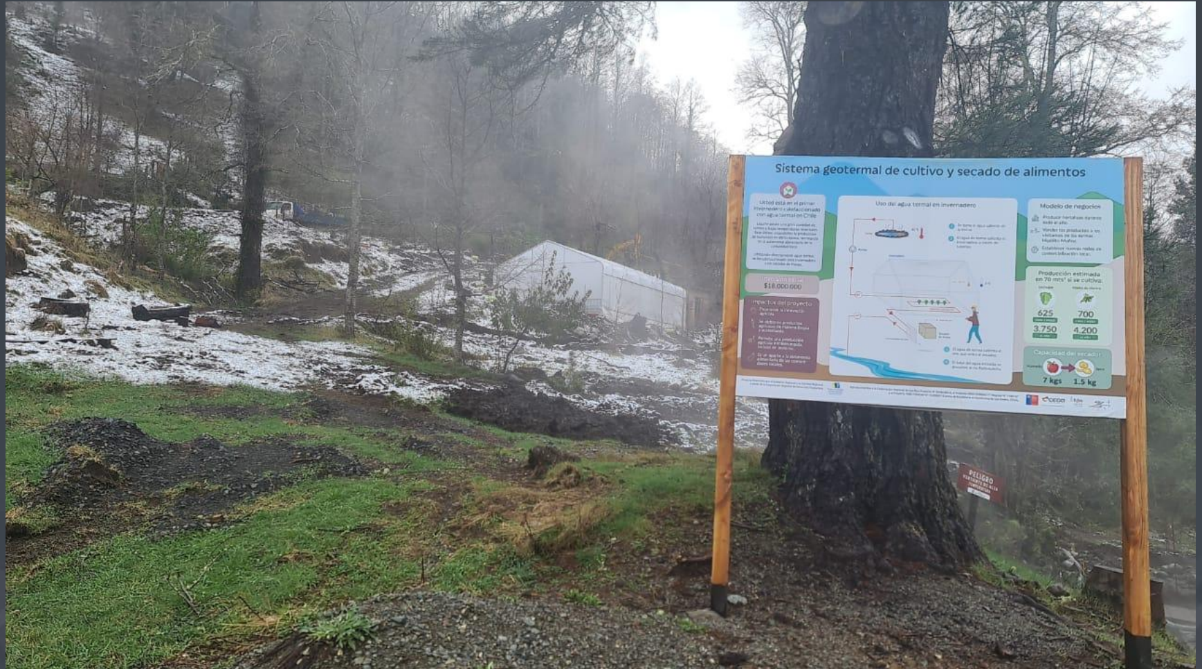
Invernadero geotérmico en Liquiñe
