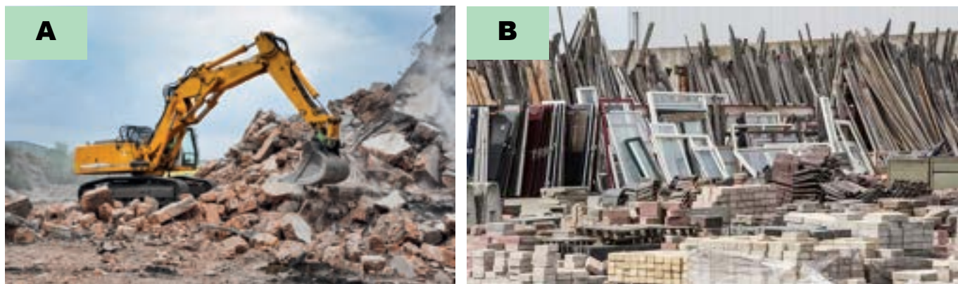
FIGURA 12. A: DEMOLICIÓN CONVENCIONAL (CONARSAC, 2023); B: DEMOLICIÓN SELECTIVA (ARCHDAILY, 2023).
