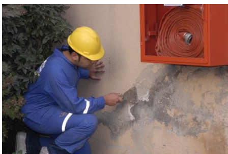
Figura 11. Ejemplo de reparación de muros de estructuras en obras de construcción (LCC, 2023)
